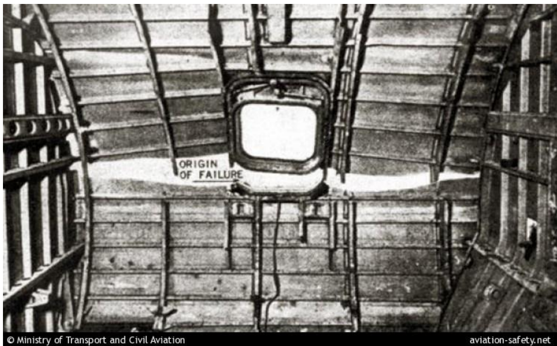
Cause de rupture à la fatigue (efforts alternés)
